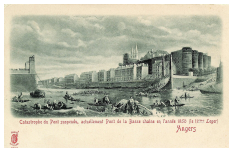
(a) Pont de la Basse-Chaine, Angers (1850)
